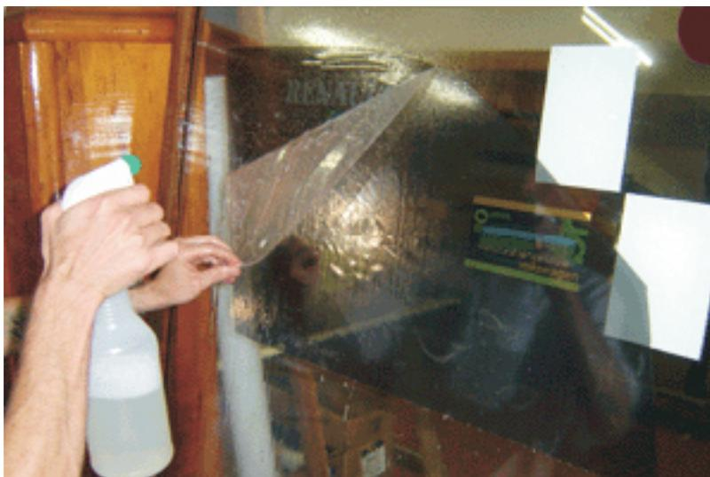
**Depois de preparado a película Titanium®, voltemos ao vidro. Molhe sua superfície interna com a solução de montagem, deixando-a escorrer.**
